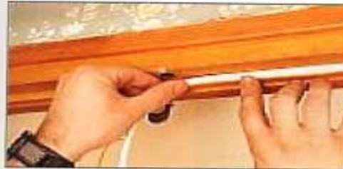
Bas de porte avec joint à basculement
