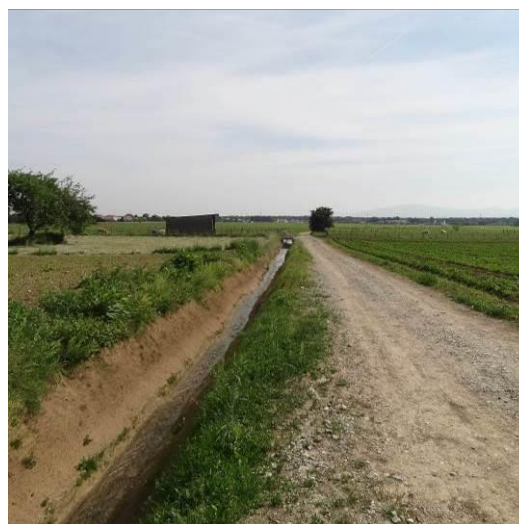
Le nouveau fossé qui récolte désormais les eaux du ruisseau dans la plaine agricole entre les lieux-dits Heisserstein et Am Baseler Weg
