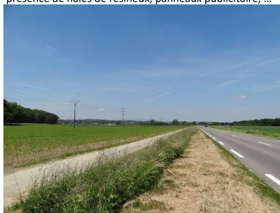
Lignes électriques le long de la RD 201
